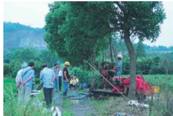
ボーリング調査 Boring survey
