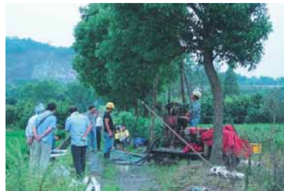
ボーリング調査 Boring survey
